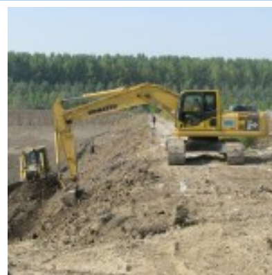
Izgradnja deponije „Srem Mačva“
